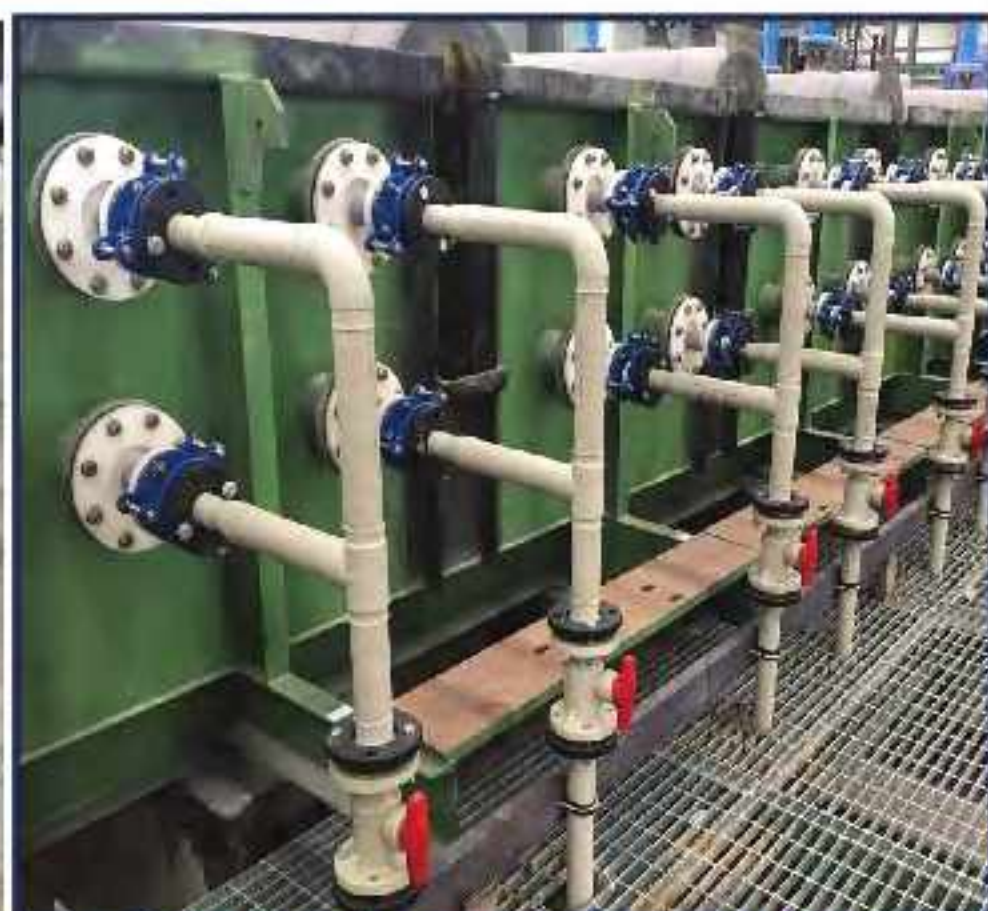
LẮP ĐẶT ỐNG & PK NHỰA PPH PPH PIPE & ACCESSORIES INSTALLATION
