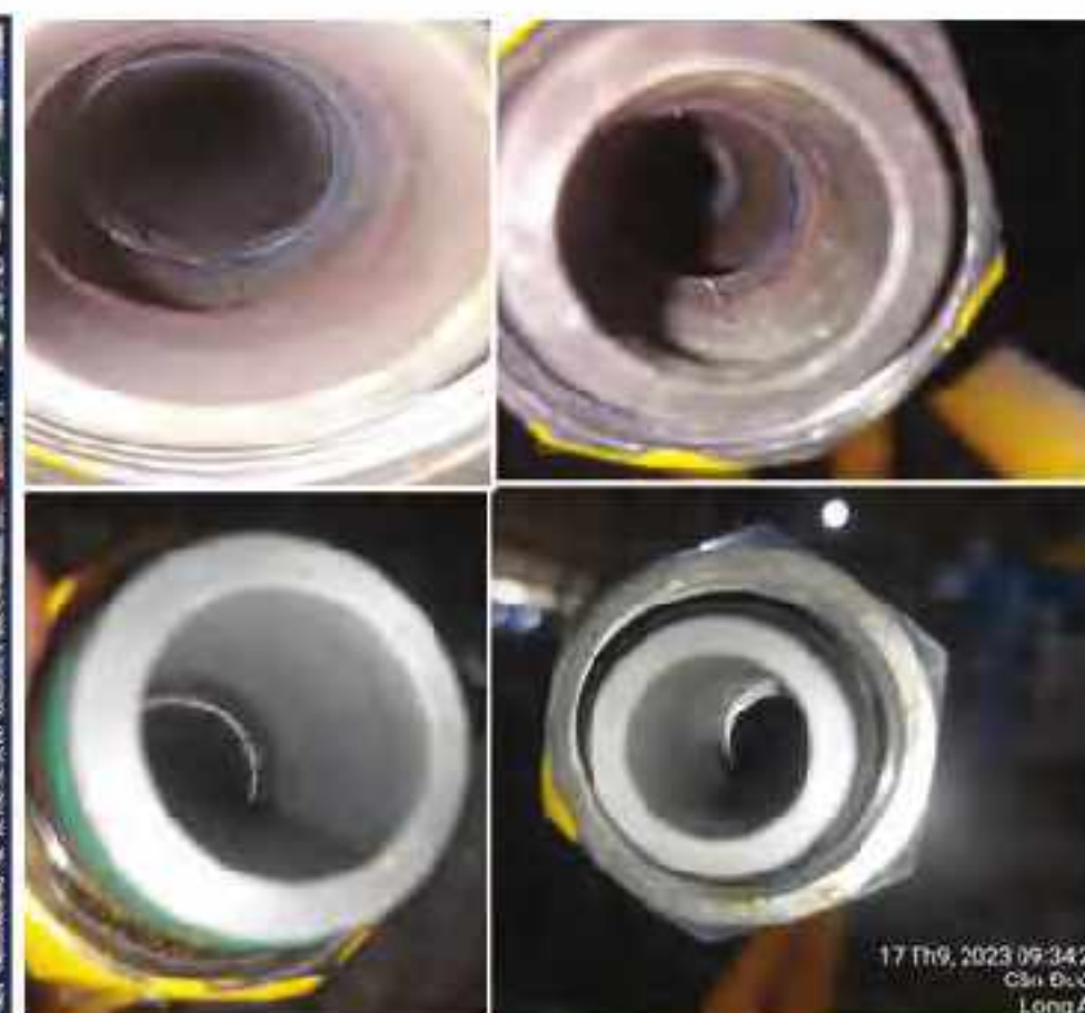
SÚC RỬA ĐƯỜNG ỐNG CLEANING & FLUSHING PIPING
